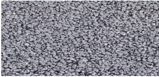
Hình 11. Mặt đường BTNRTN sau khi lu lèn
