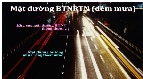
Hình 1. Mặt đường bê tông nhựa thông thường và bê tông nhựa rỗng thoát nước khi trời mưa
